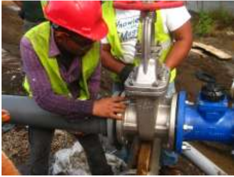
Instalación de Tubería de Conducción de 6" para dar inicio a prueba de bombeo.
