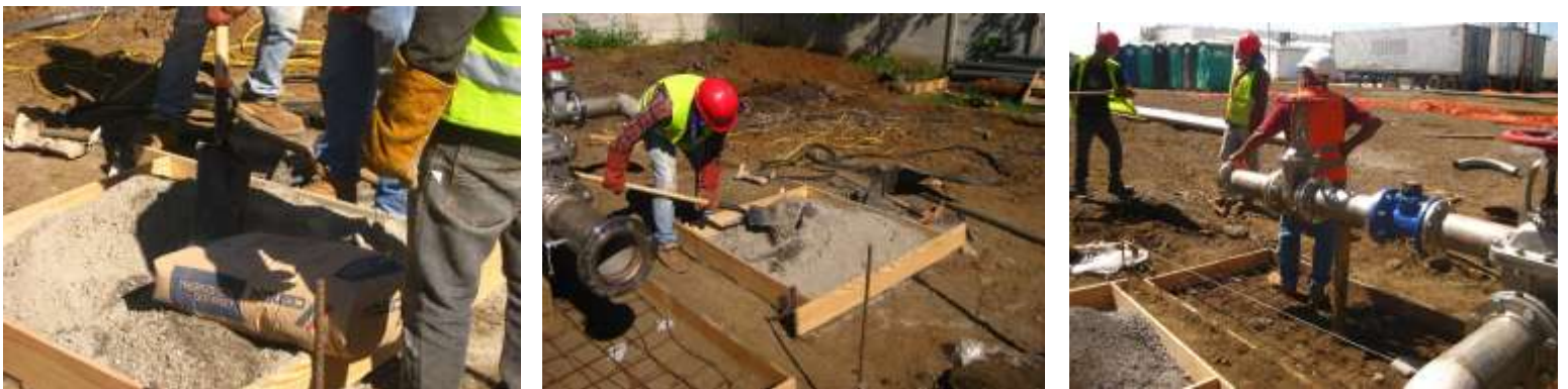
Realización de formaleta para loza de concreto, realización de mezcla para loza.
