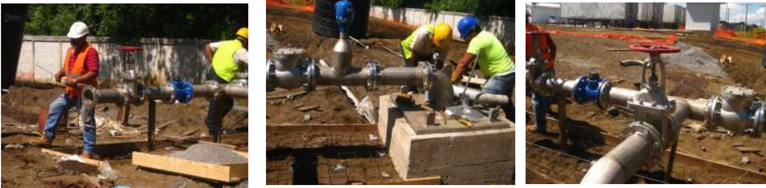
Instalación de tubería sarta de descarga, pozo Cargill.
