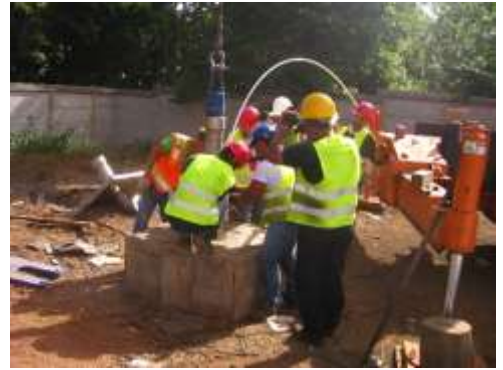
Personal de Sinter Instalando
