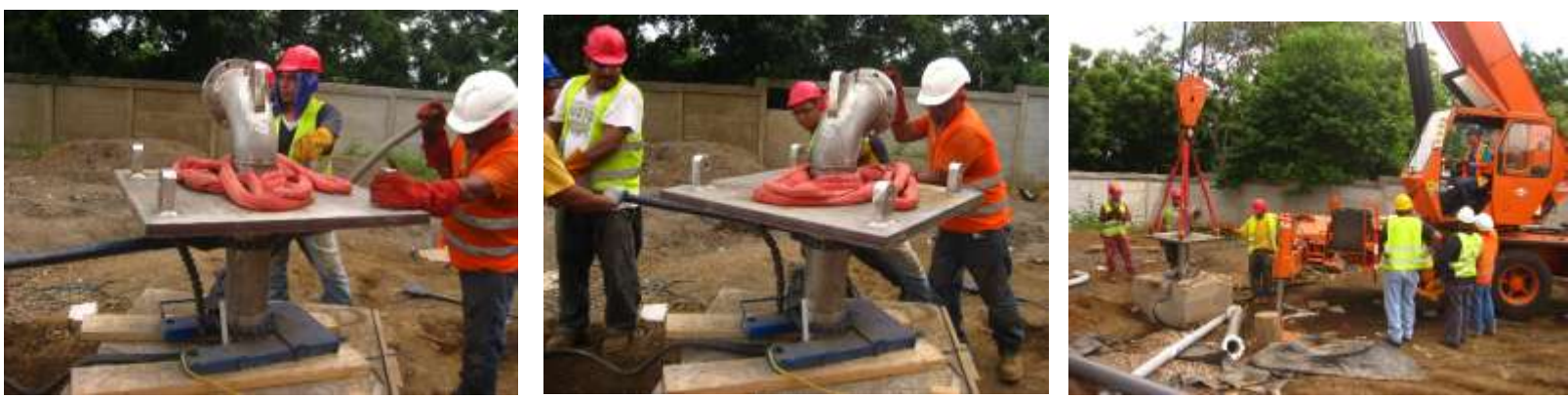
Instalación de Plato soporte y codo de descarga pozo Cargill.
