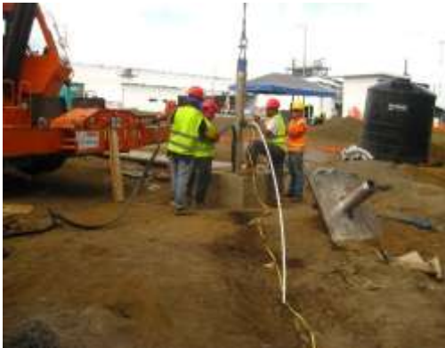
Introducción de tubería, cable sumergible, tubería piezométrica y cable TSJ para electrodos.
