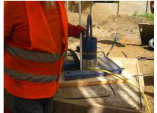
Introducción de tubería, cable sumergible, tubería piezométrica y cable TSJ para electrodos.
