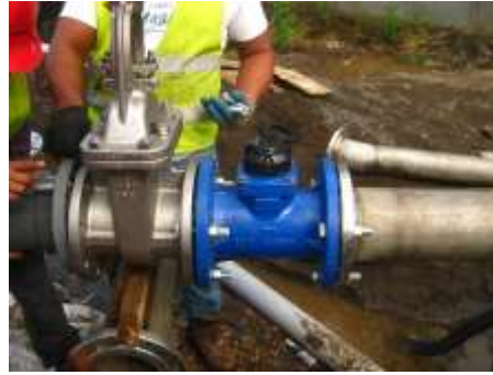
Instalación de Tubería de Conducción de 6" para dar inicio a prueba de bombeo.
