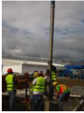
Levantamiento de tuberías
