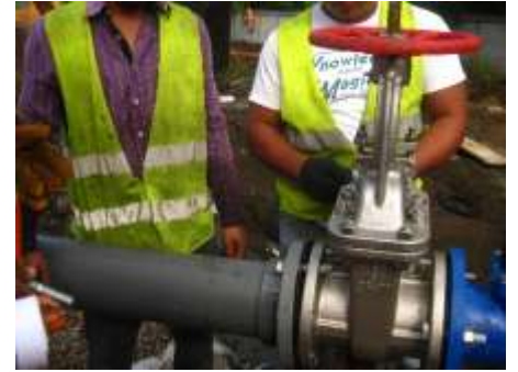
Instalación de Tubería de Conducción de 6" para dar inicio a prueba de bombeo.
