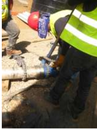
Instalaciones de camisa en tubería de acero inoxidable.
