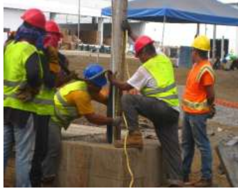
Introducción de tubería, cable sumergible, tubería piezométrica y cable TSJ para electrodos.
